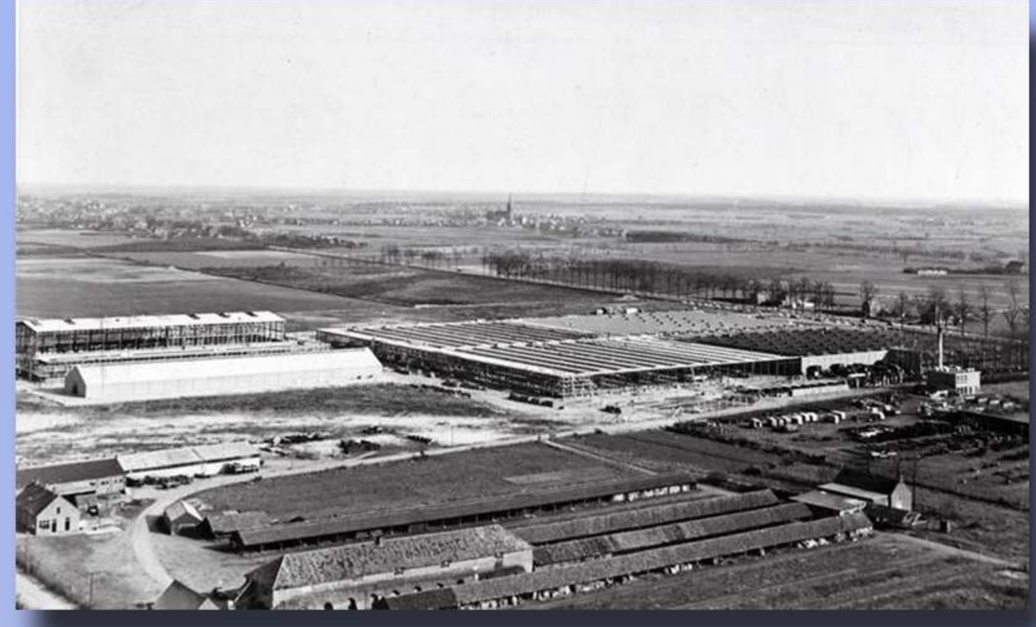
Machinale steenfabriek De Vlijt. Glaudemans & van Gestel - Machinale steenfabriek De Vlijt gevestigd aan het eindhovens kanaal
