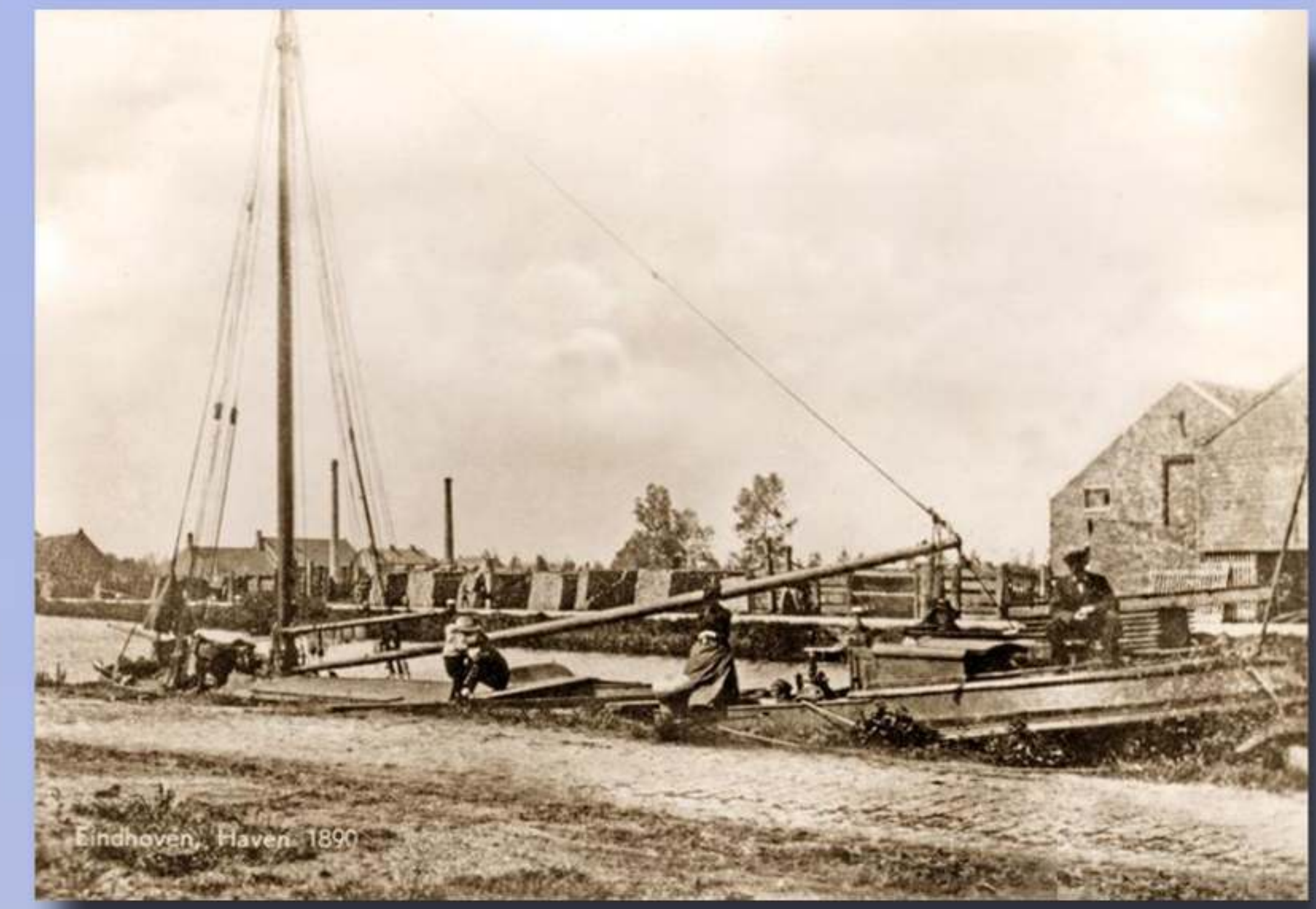
Eindhovens Kanaal, de zwaikom 1890. De gebouwen en stapels stenen op de achtergrond zijn van Glaudemans & van Gestel - Machinale steenfabriek De Vlijt.
