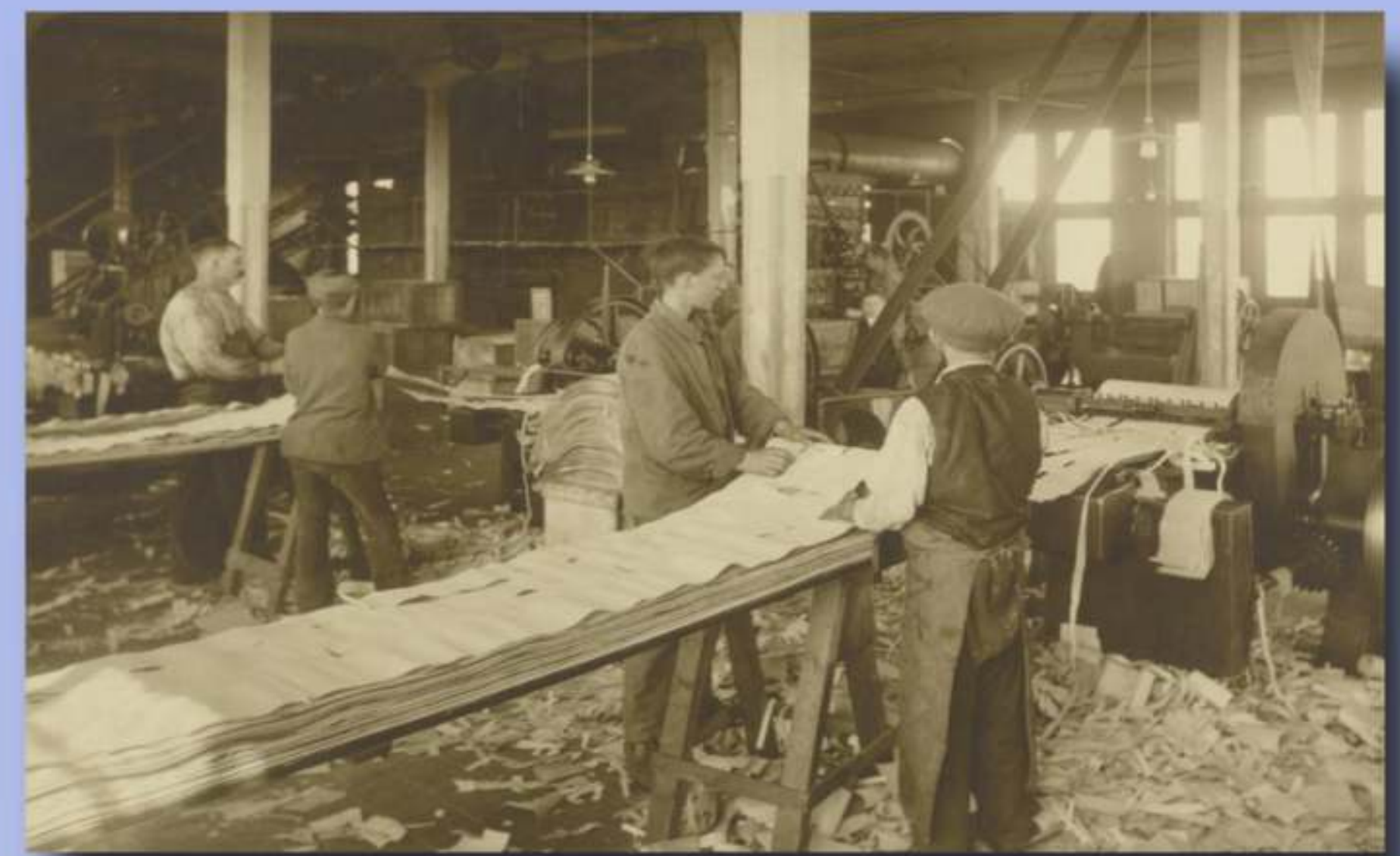
Afrolmachine voor de huizen van de doosjes. Een houtblok wordt afgerold tot lange dunne stroken, die later op de vereiste maat worden afgesneden. De laadjes der doosjes en de houtjes worden op gelijke machines bewerkt, doch de stroken hebben dan een andere afmeting.
