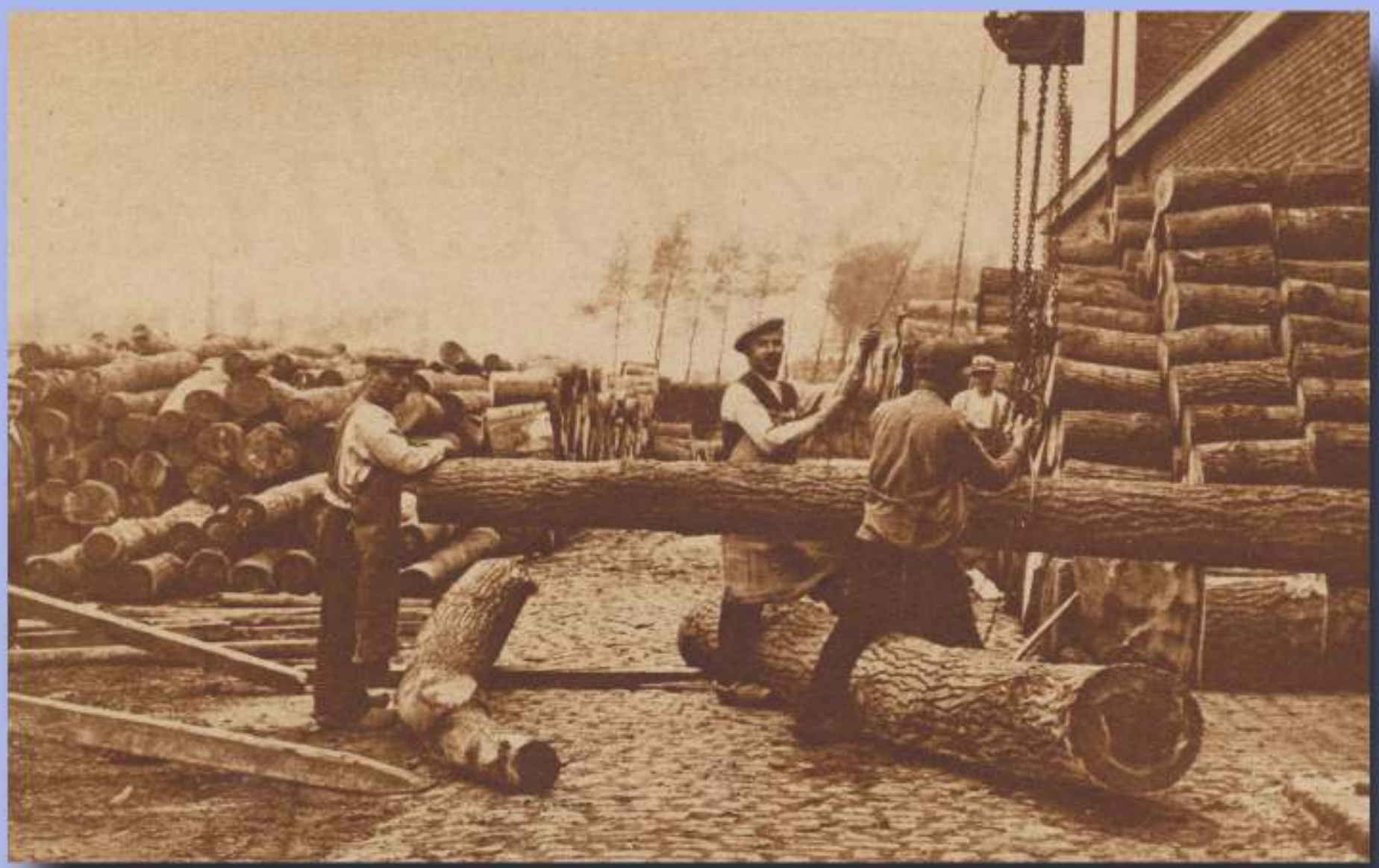
De lucifer wordt vervaardigd van espenhout, dat uit Rusland en Finland wordt ingevoerd, inlands populierenhout kan voor de bewerking dienen. De boomstammen worden in de elektrische zagerij in blokken van circa 60 cm verdeeld.
