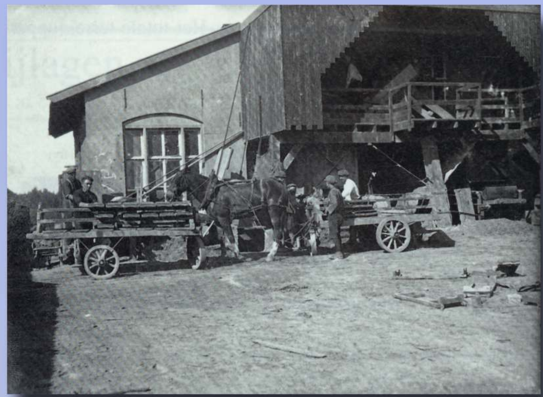
Steenfabriek W. van Hapert & Co. te Woensel in de jaren twintig: het persen van stenen en het transport naar de droogloods.
