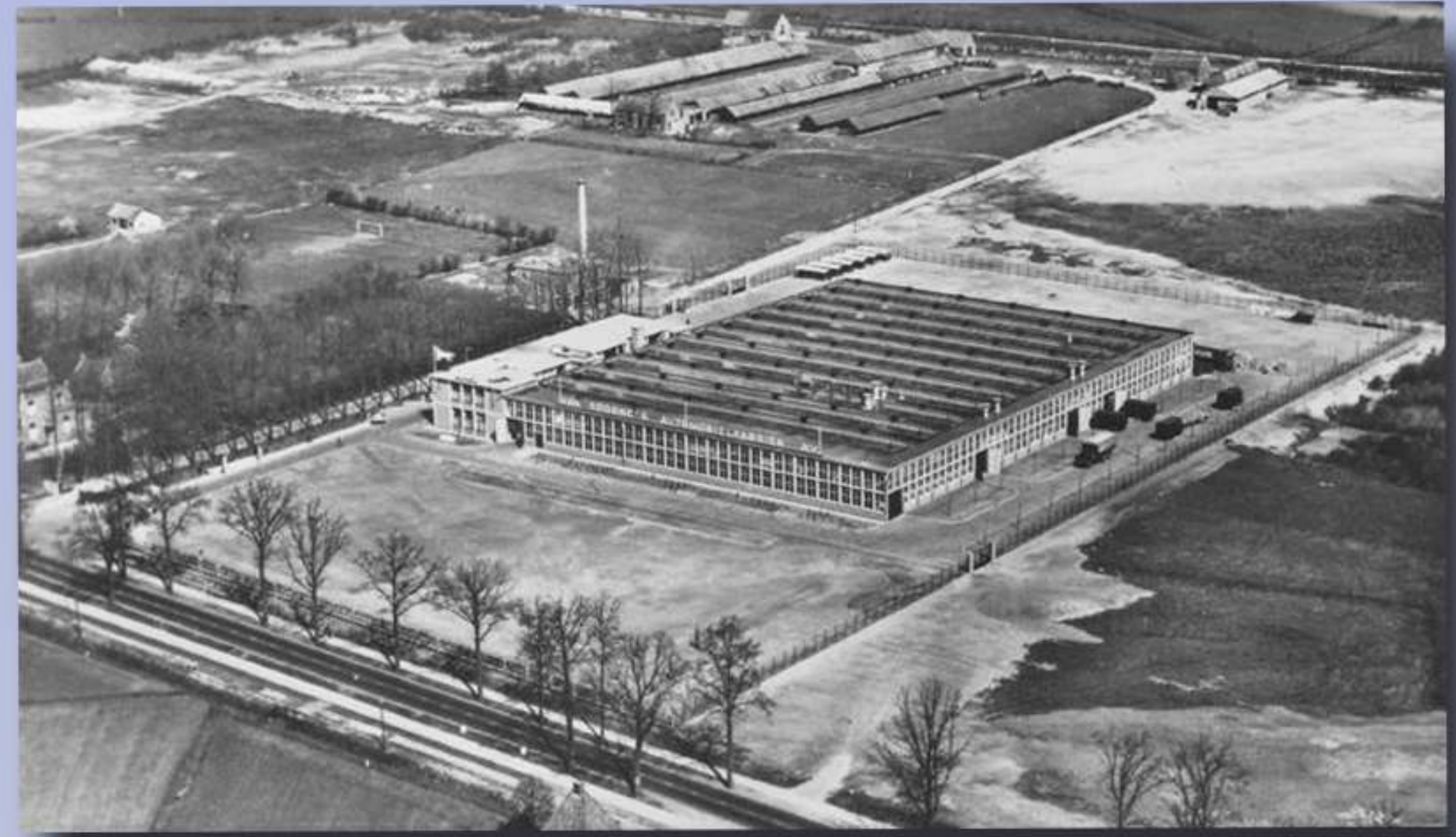
Daf fabriek en boven de steenfabriek van de firma Gloudemans 1951
