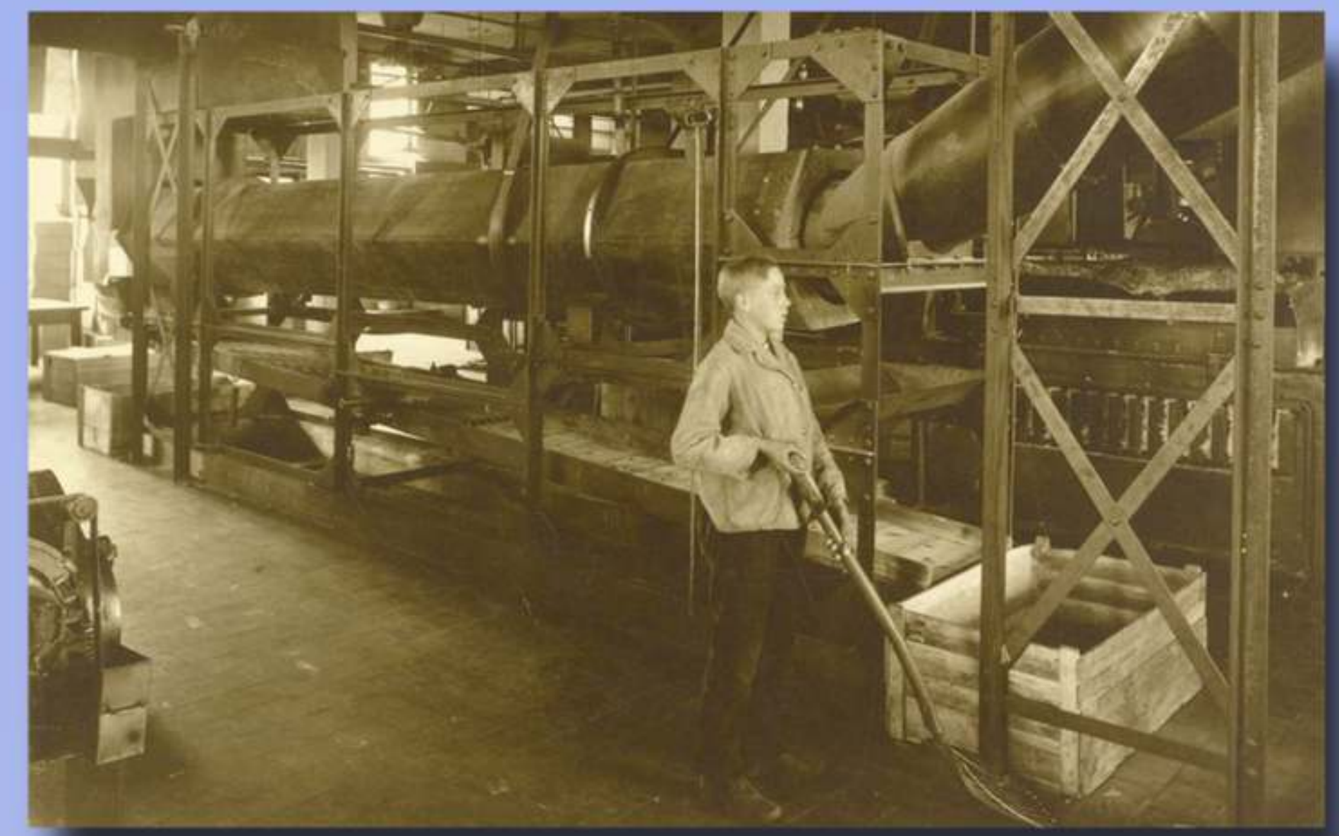
Builmachine; de houtjes worden glad geschuurd in een draaiende trommel, waarna de gebroken stukjes door een zeef vallen; de lucifers komen in de schokmachine terecht waar ze worden geordend en in rekken geplaatst. De jongen bedient beide machines.
