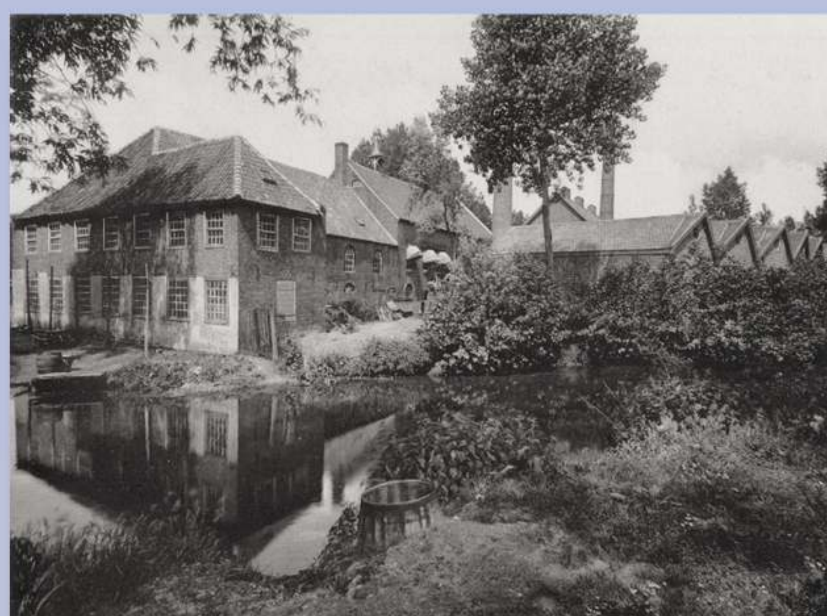
De trijpfabriek van Schellens & Marto, 1916. Links en rechts van de boom zijn de twee schoorstenen van de trijpfabriek te zien. De fotograaf stond op de berm tussen de Dommel en de Nachtegaallaan.
