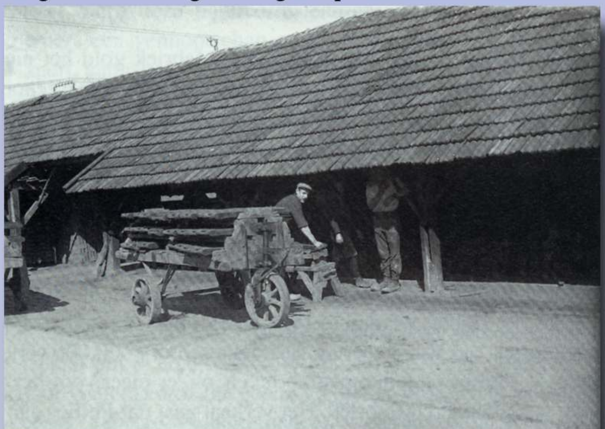
Steenfabriek W. Van Hapert & Co te Woensel in de jaren twintig: transport van gevormde stenen naar droogrekken en loodsen
