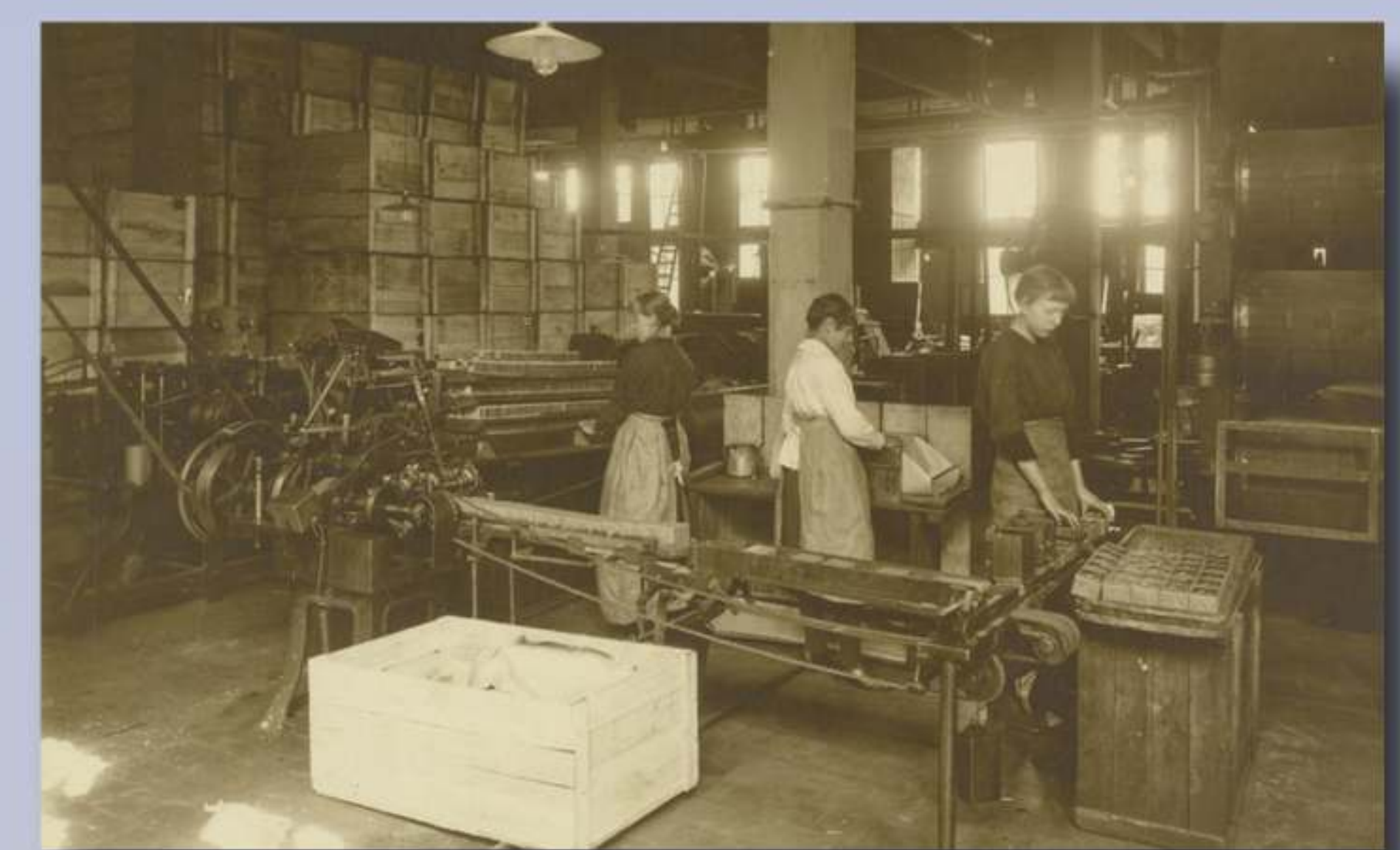
Pakmachines voor luciferdoosjes waar de pakken worden gemaakt en een etiket opgeplakt. Deze machine sluit aan op de vorige.
