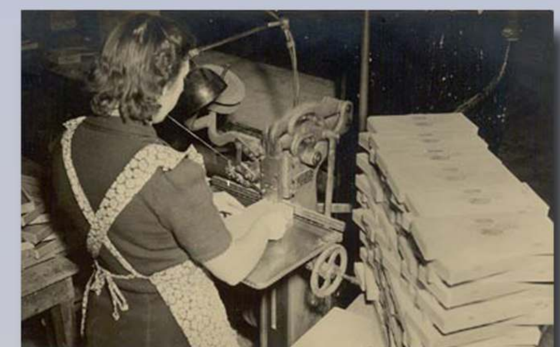
De fabricage van sigarenkistjes bij de Picus vlak voor de oorlog. De machine waar deze jongedame aan werkt, is een hechtmachine. Hier werden de bodems aan de kistjes bevestigd met nieten. Het ijzerdraad voor die nieten zat op een grote spoel op de machine.
