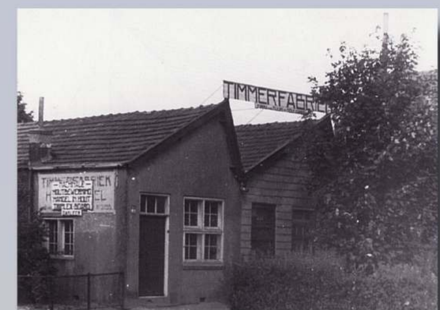
Timmerfabriek /werkplaats van Frans en Jan van Tuijn, op de hoek van de Zeelsterstraat / Klauwierstraat (Bredalaan).
