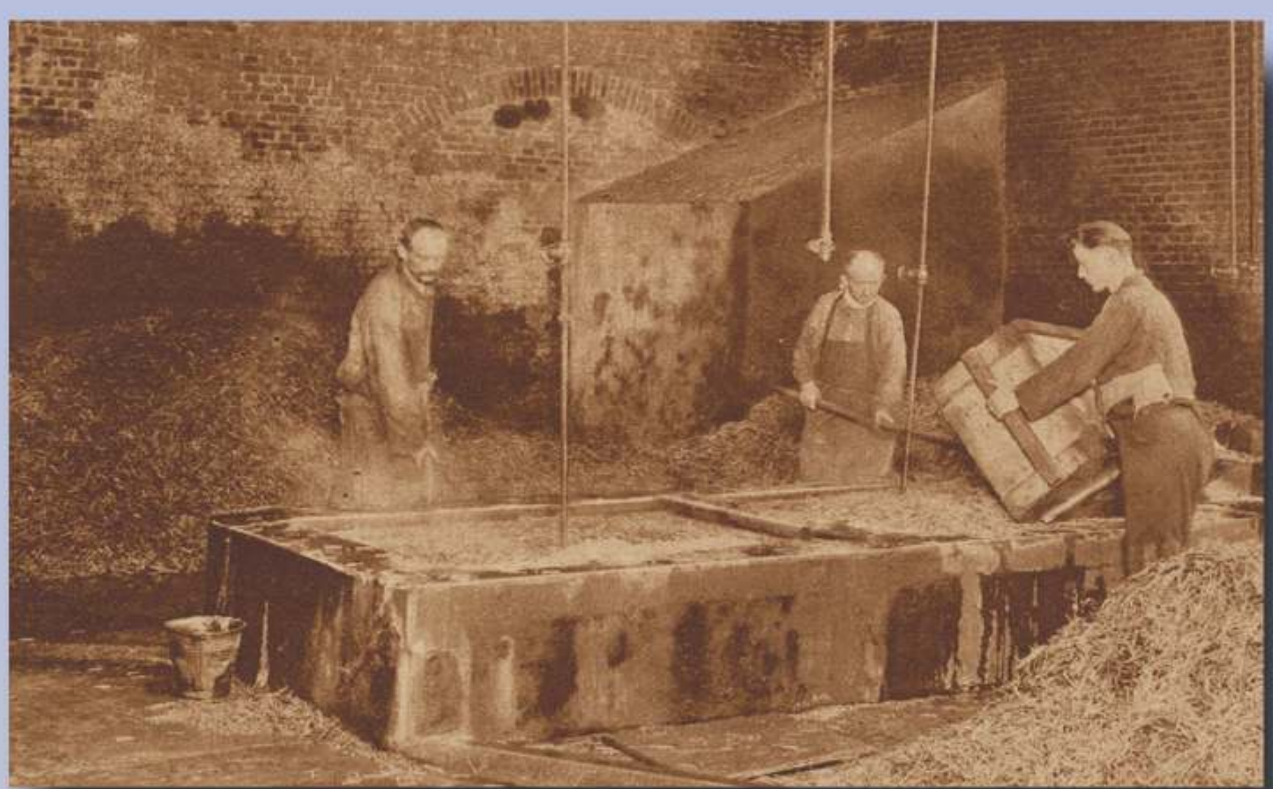
De miljoenen stokjes worden in bakken gestort, die gevuld zijn met rode verfstof. Het kleursel is warm, waardoor de rode vloeistof vlugger in het hout trekt. Eigenlijk is deze bewerking overbodig, want de witte lucifers branden evengoed als de rode, doch de beter-wetende afnemers zijn de mening toegedaan dat witte lucifers van mindere kwaliteit zijn. Vandaar het roodverven.
